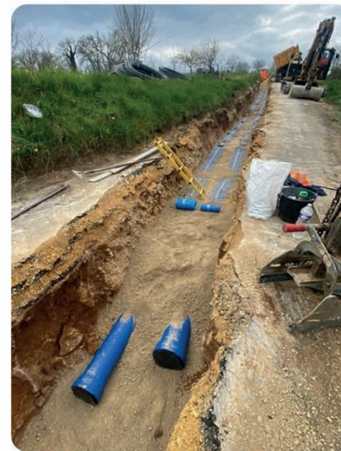
Chantier d'alimentation des réservoirs de Boutenègre
