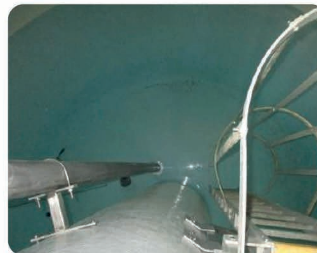
Réservoir de Miallet
