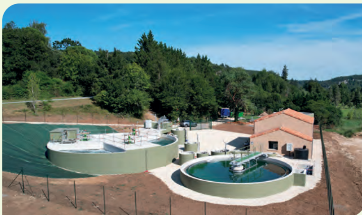
Travaux de la station d'épuration des Eyzies, le coût du projet s'élève à 2 300 000 € HT.
