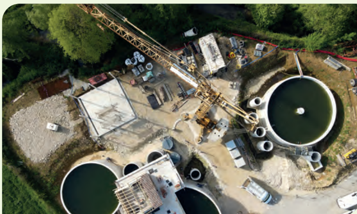
Travaux de la station d'épuration de Salviac, le coût du projet s'élève à 2 500 000 € HT.
