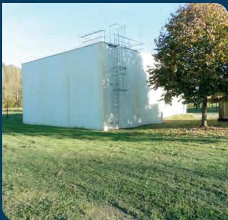
Station de prélèvement et production de Coly.
