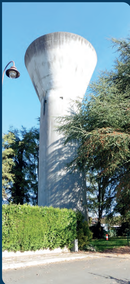
Réservoir sur tour de Sébasture, Salignac-Eyvigues.
