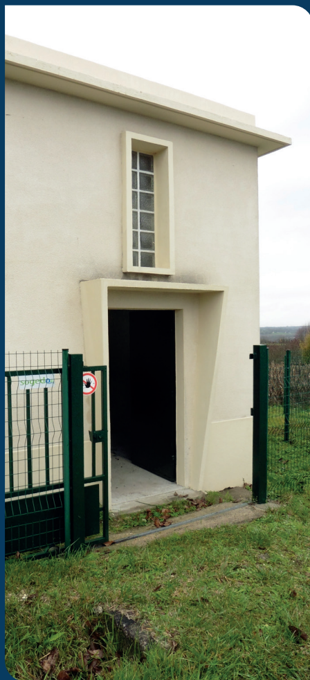
Réservoir semi-enterré des Berthoumeries, Tocane-Saint-Apre.
