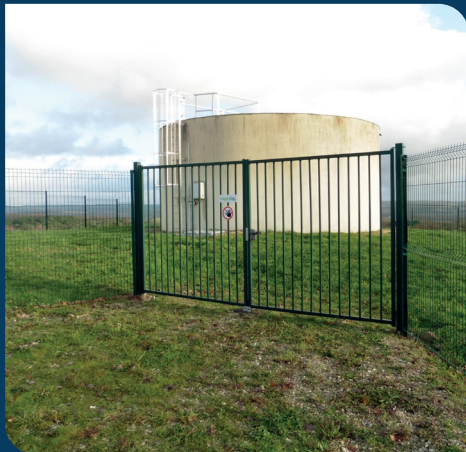
Réservoir semi-enterré de Montaufy, Tocane-Saint-Apre.
