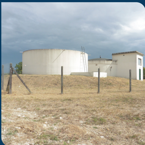
Réservoir semi-enterré Des Martelles, Bouteille-Saint-Sébastien.
