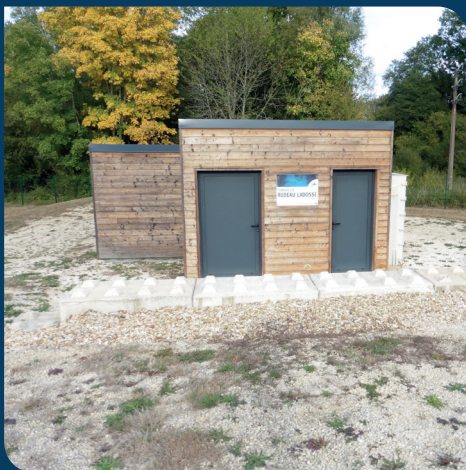
Forage de Rudeau-Ladosse.
