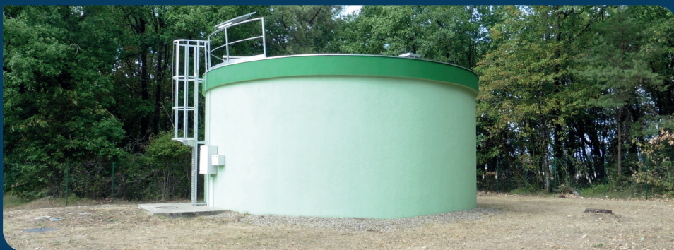
Réservoir semi-enterré Les Ages, Saint-Martial-Viveyrol.
