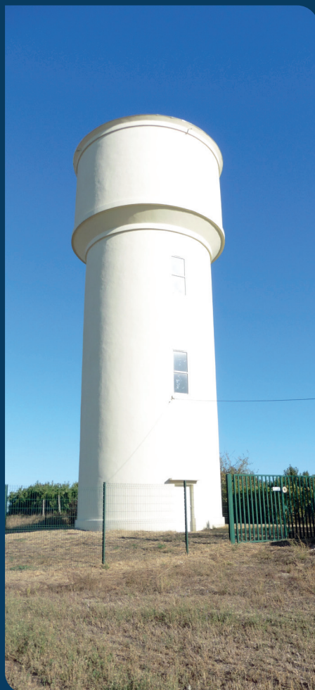
Réservoir sur tour de Goudail, Verteillac La Tour-Blanche.
