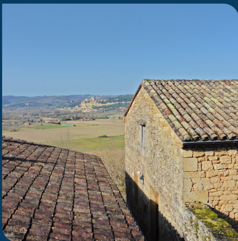
Réservoir semi-enterré de Marqueyssac.
