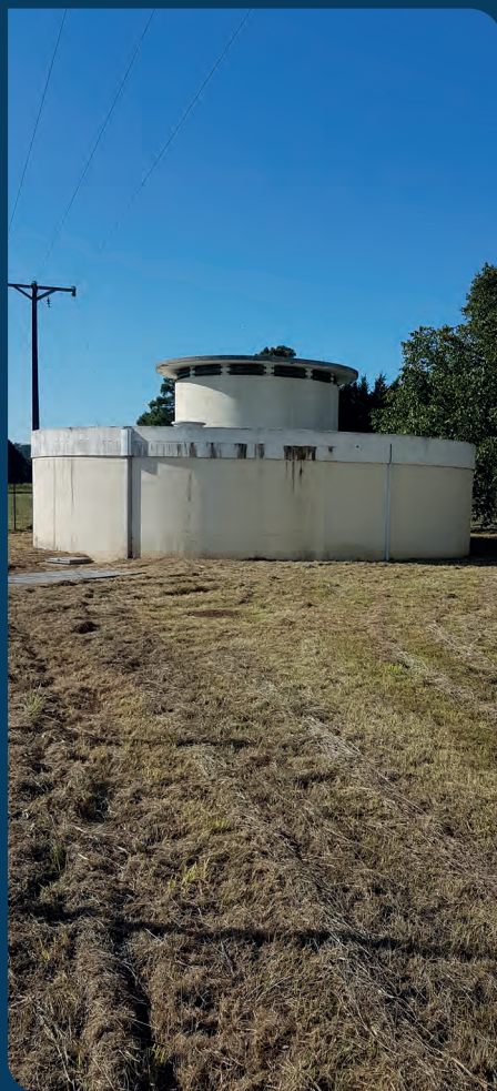
Forage et station de production de Thuilière, Saint-Front-de-Pradoux.
