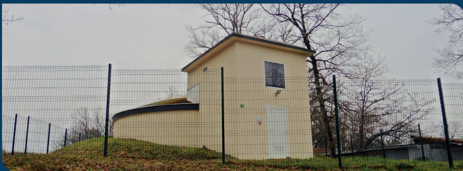
Réservoir semi-enterré et surpresseur de la Brande, Saint-Pardoux-la-Rivière.
