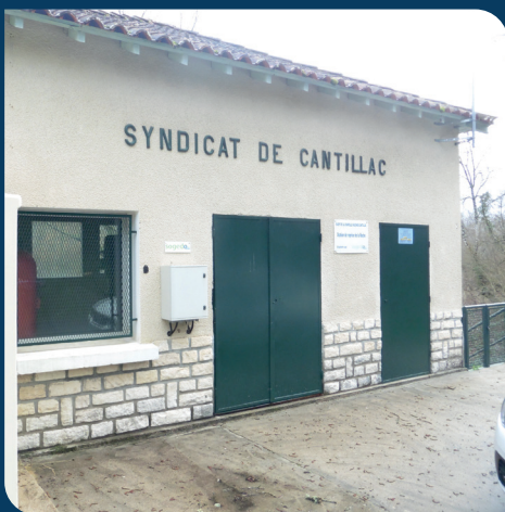
Puits, forage et station de production de La Roche, Quinsac.
