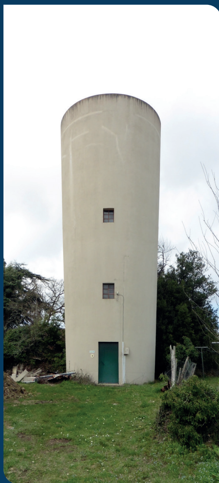
Réservoir sur tour du Bourg de la Gonterie-Boulouneix, Brantôme en Périgord.
