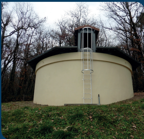
Réservoir semi-enterré de Janou, Villars.
