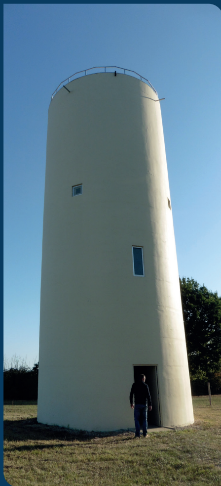
Réservoir sur tour, Site de Berboullès, Saint Léon sur Vézère.
