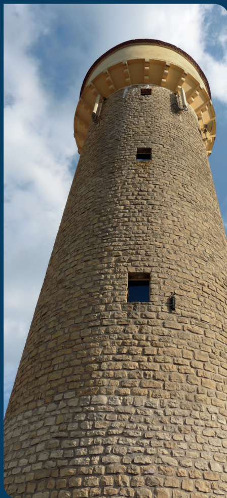
Réservoir sur tour, Tournehil, Belvès.
