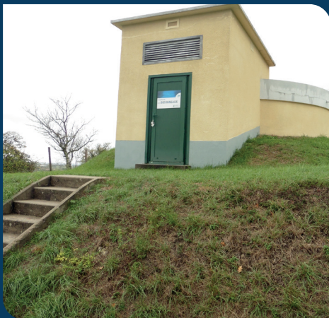
Réservoir semi-enterré des Bidonneaux, Saint Martin de Ribérac.
