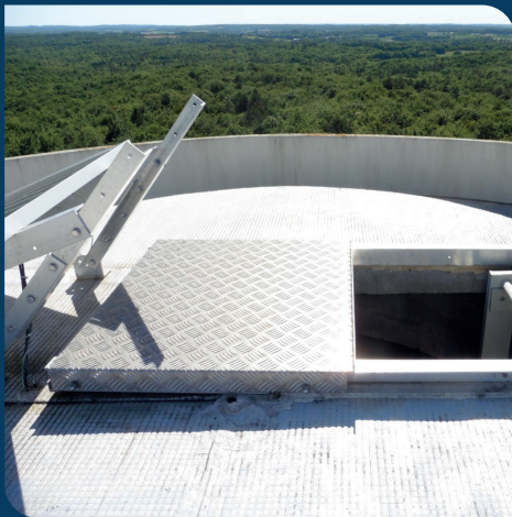
Réservoir semi-enterré de l'Age, Coulaures.
