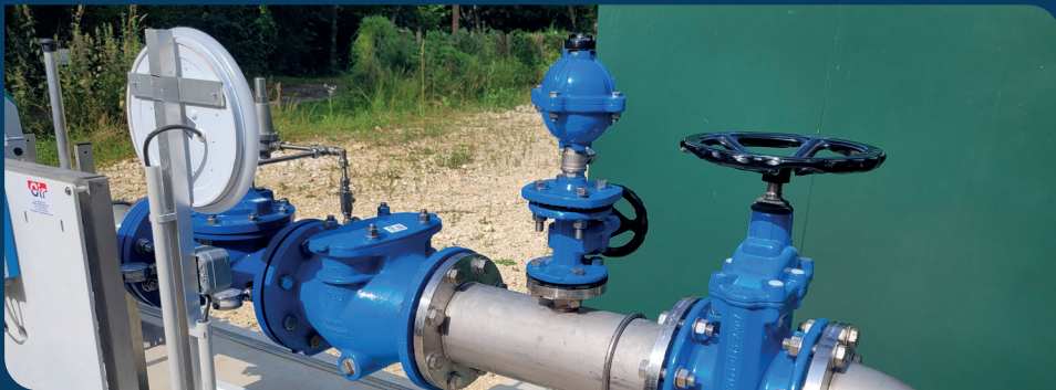
Forage de la Glane, Saint-Jory-Las-Bloux.
