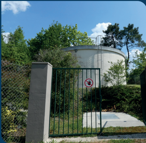
Réservoir semi-enterré, Cap de fer, Vélines.
