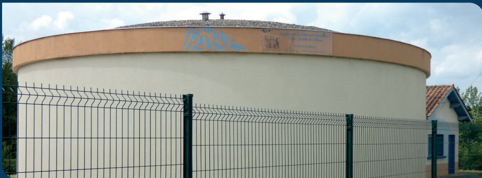
Réservoir semi-enterré, Maya, Fougeyrolles.
