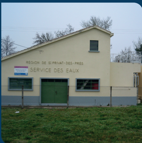
Station de traitement de Moulin Neuf, Saint Privat.
