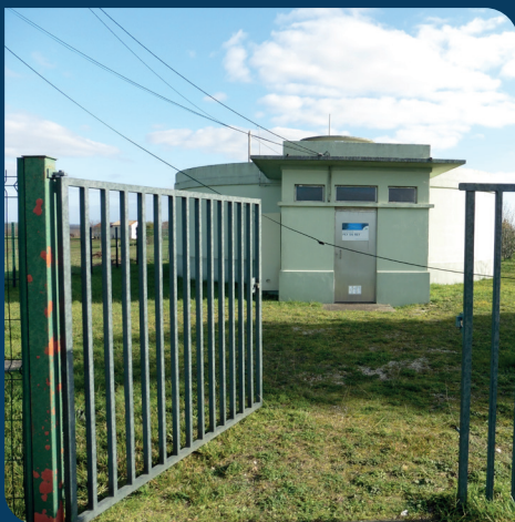
Réservoir semi-enterré de Pey de Rey, Saint Aulaye.
