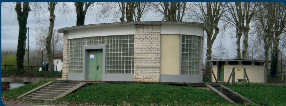
Station de traitement de la Plage, Saint Aulaye.
