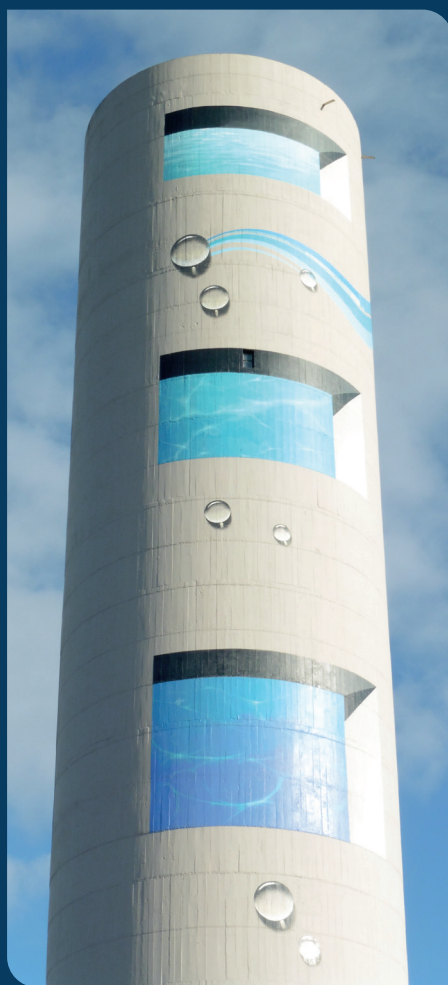
Réservoir sur tour de Puymangou, La Poste, Saint Aulaye.
